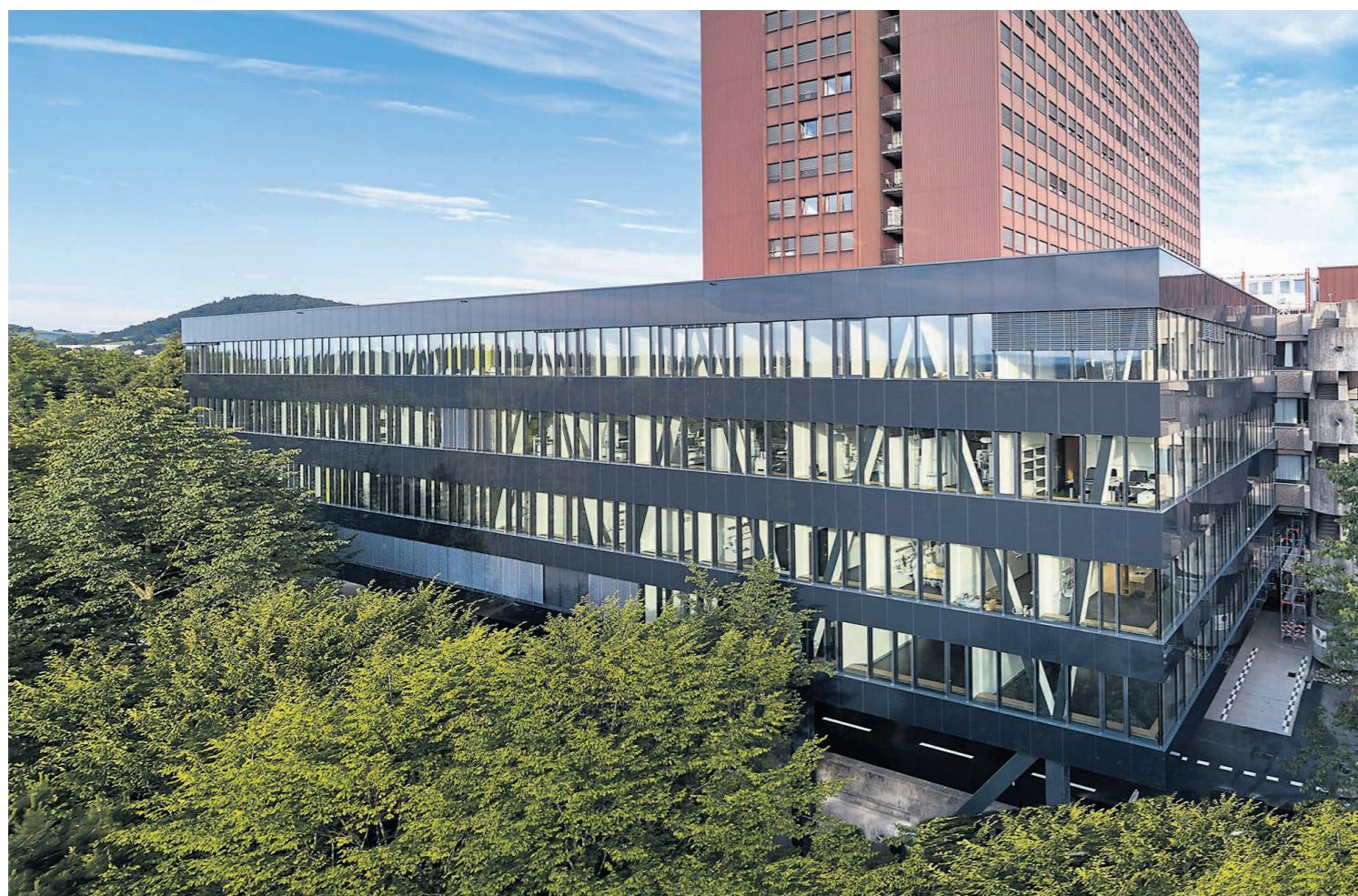
Das LUKS setzt mit dem neuen viergeschossigen Bau wichtige Akzente in der hochstehenden Versorgung von Patientinnen und Patienten mit schweren akuten Erkrankungen und schweren Verletzungen der ganzen Zentralschweiz. Bilder: PD
