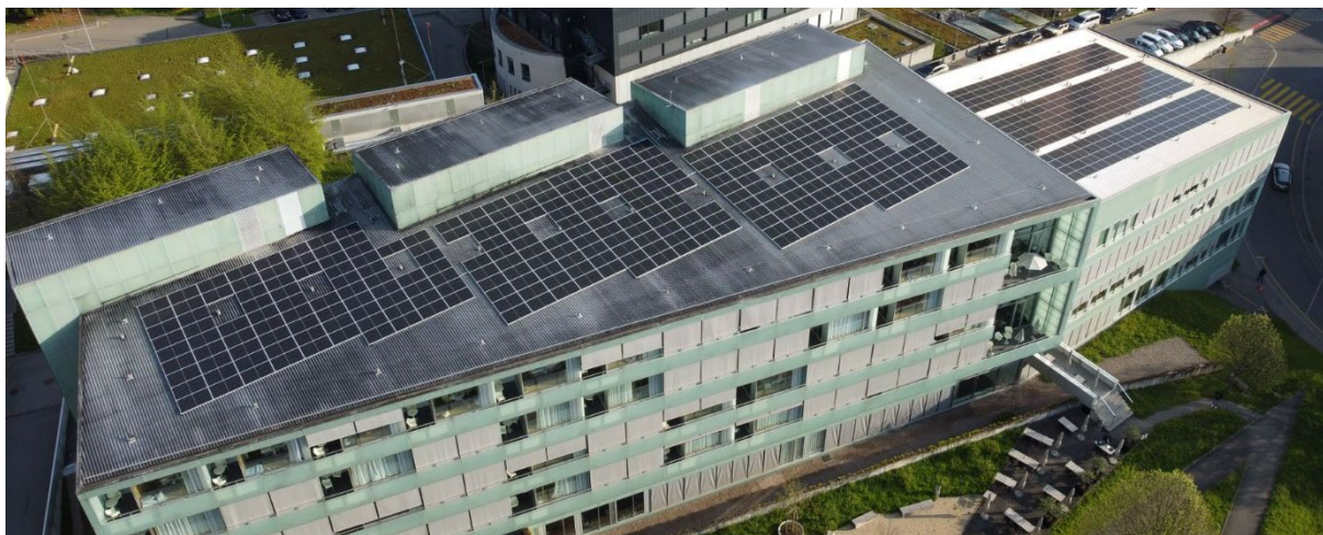
Abbildung 6: PV-Anlagen auf dem Dach der Frauenklinik
