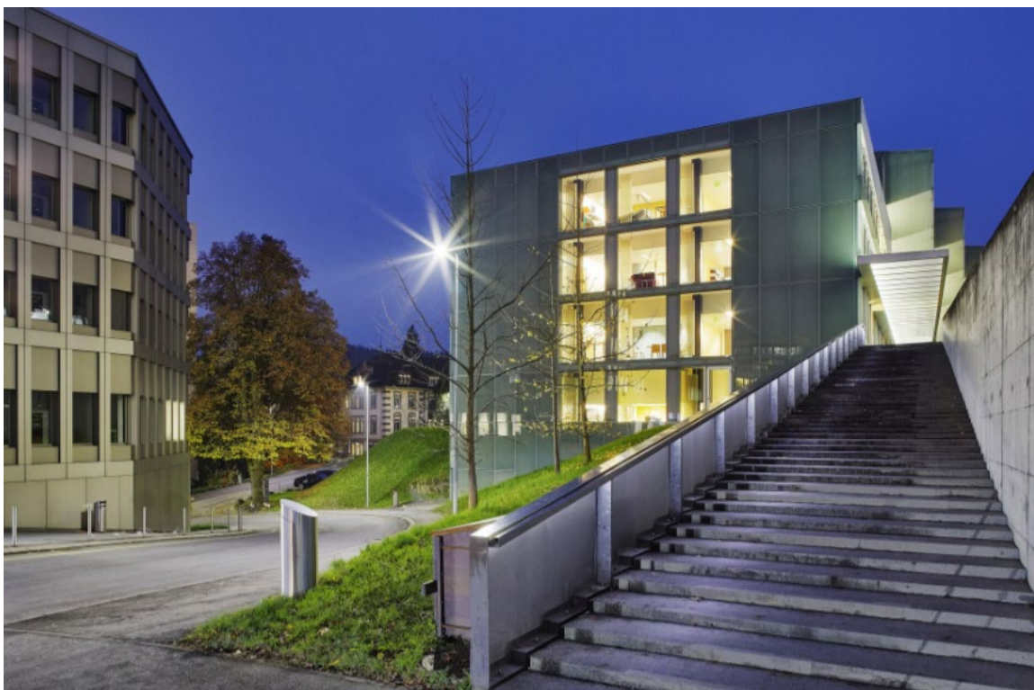
Abbildung 9: Beispiel energieeffizienter Beleuchtung
