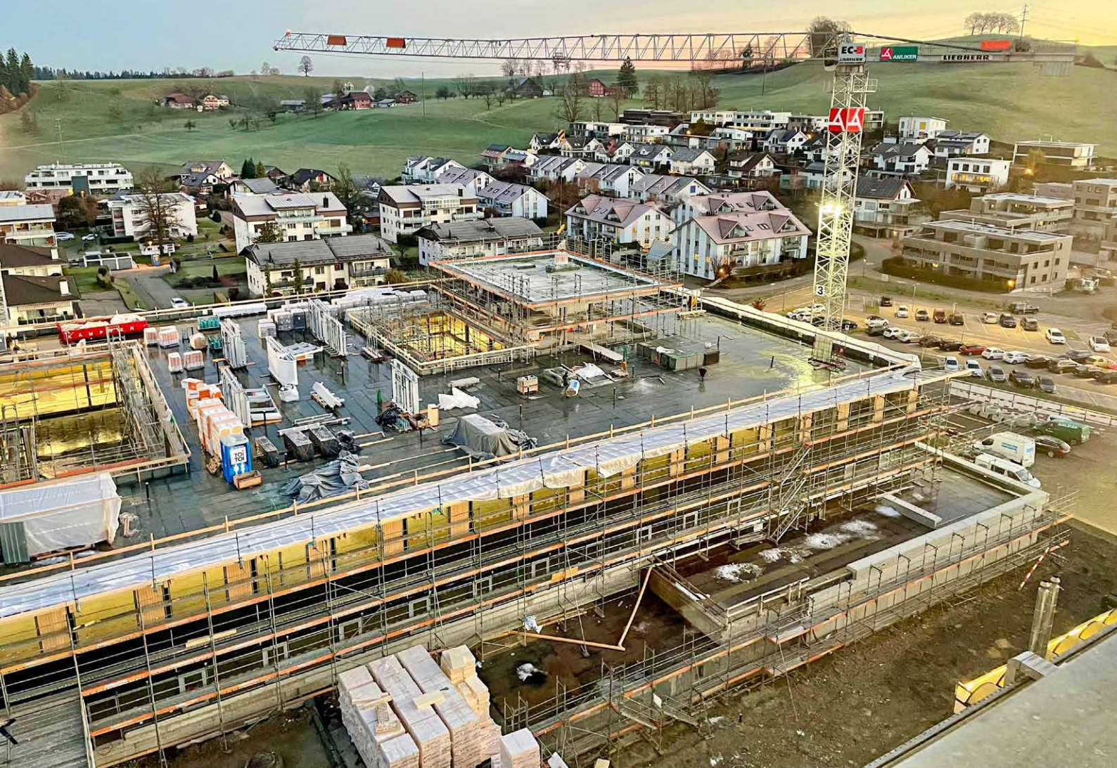
Baustelle Spitalneubau LUKS Wolhusen.
